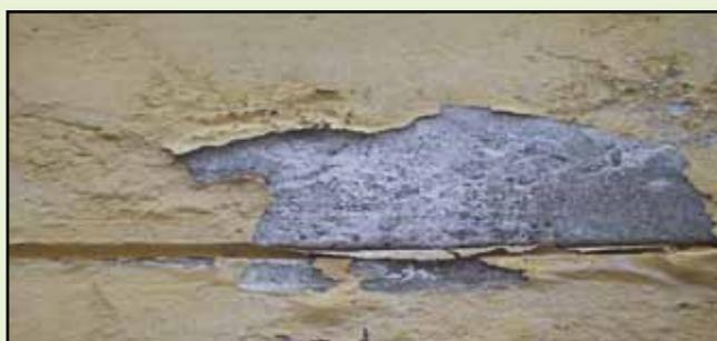
*Fotografía N° 1. Las eflorescencias abomban y desprenden la pintura de un paramento.*
