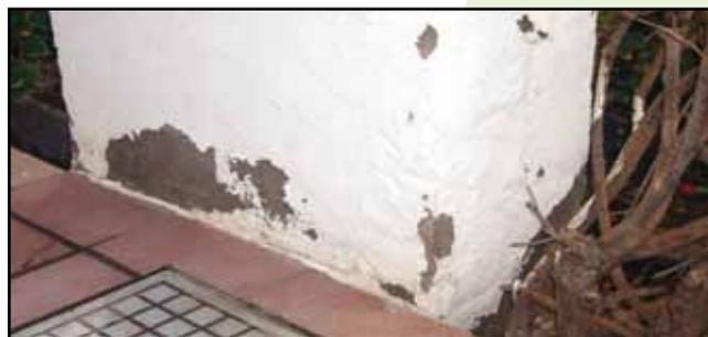
*Fotografía N° 5. La humedad del jardín asciende por los capilares del mortero y los bloques desprendiendo la pintura.*
