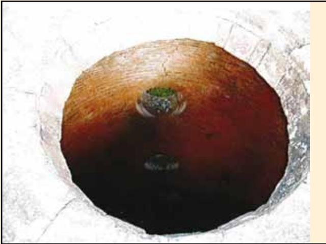
*Boca Superior del Horno de El Madroñal para el escape del humo. Foto: P. Socorro.*
