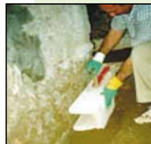
Fotografía N° 11. Sistema de perfiles en "U" (Servicio de Rehabilitación COAAT Sevilla).
