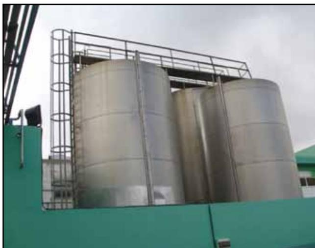
Fotografía N° 3. Depósitos de almacenamiento (AISI 304)
