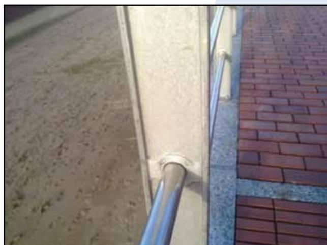
*Fotografía N° 14. Vista del balaustre después de la limpieza. Playa de Las Canteras.*
