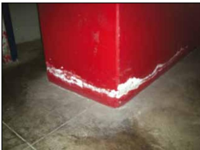
*Fotografía N° 4. La humedad del subsuelo se evapora y las sales disueltas se expanden y desprenden la pintura.*
