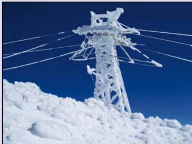
Durante la vida de las torres fue necesario sustituir varios perfiles afectados por estas deformaciones que se colocaron sin la tensión que debieran soportar, creando distorsiones en el esquema resistente de la estructura. Antes de la renovación, el estado de las torres producía movimientos indeseables durante la explotación, provocando falta de alineación de los apoyos de los cables, que aconsejaron abordar el cambio de las estructuras de las torres.
