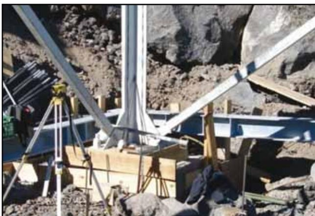
También fue necesario el recrecido de algunas de las bases de cimentación con hormigón armado. Es fácil imaginar las dificultades para realizar la puesta en obra del hormigón. Por último, se realizó una rehabilitación completa de todos los paramentos de hormigón de los cimientos, sellado de grietas, tratamientos para las armaduras, tratamiento de impermeabilización y pintado.
