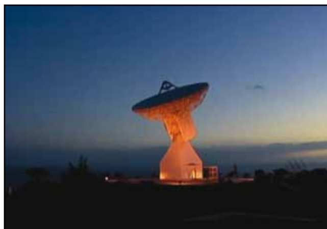
Foto N 8: Antena de 15 metros para operaciones TTC.
