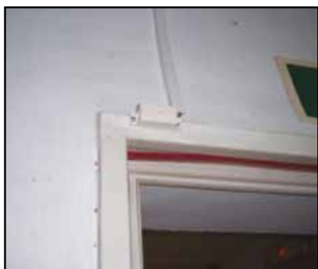
Foto N° 6: Contactos magnéticos en oficina SSTT.
