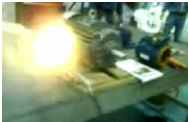
Foto N° 2: Motor que se incendia.
