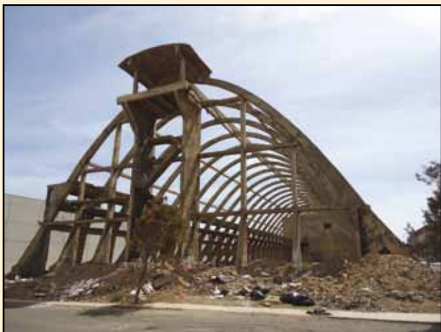
Foto N° 4: Silo de sulfato amónico de la Compañía Insular del Nitrógeno, Sociedad Anónima (CINSA) en Salinetas, Telde.
