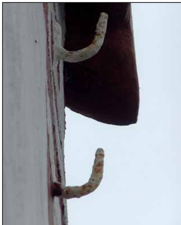
Foto N° 10: Ganchos en la vivienda de la familia Bravo, posibles restos del tendido telefónico de 1893.
