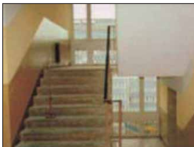
Foto N° 2: Escalera de evacuación con sistema de control de humos. ©MISTRAL®
