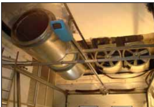
Foto N° 6: Conjunto de ventiladores (en ejecución).
