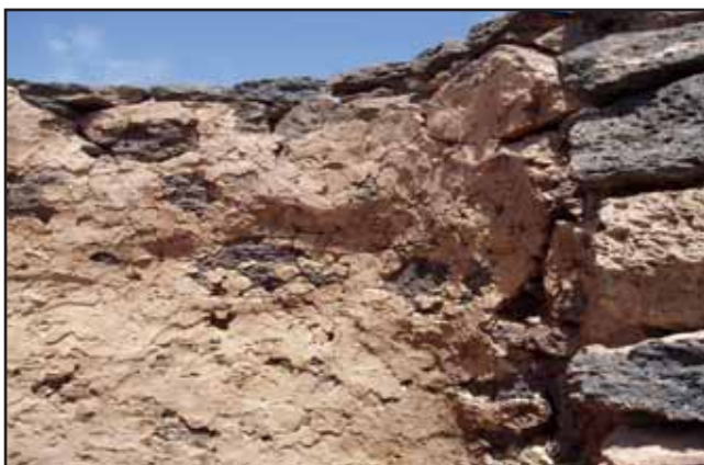
Foto N° 3: Revestimiento interior de un horno. La Oliva, Fuerteventura. 2009.
