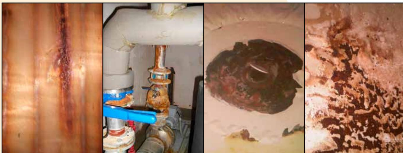
Foto N° 1: Defectos de la instalación de ACS: Pares galvánicos. Cordones oxidados de soldadura interior. Ampollamiento y caída de revestimiento interior de los acumuladores. Corrosión puntual y generalizada.
