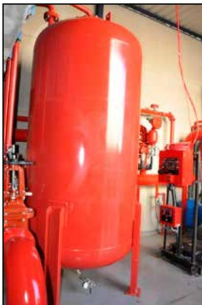
Foto N° 15: Depósito Espumógeno.
