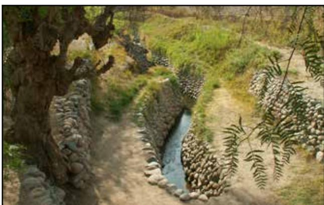
Foto N° 3: Línea de cuatro pozos de ventilación del anterior puquio, conocidos por ojos, por donde en escalera de caracol se baja hasta la galería filtrante. Nasca (Perú). Wikipedia.org.
