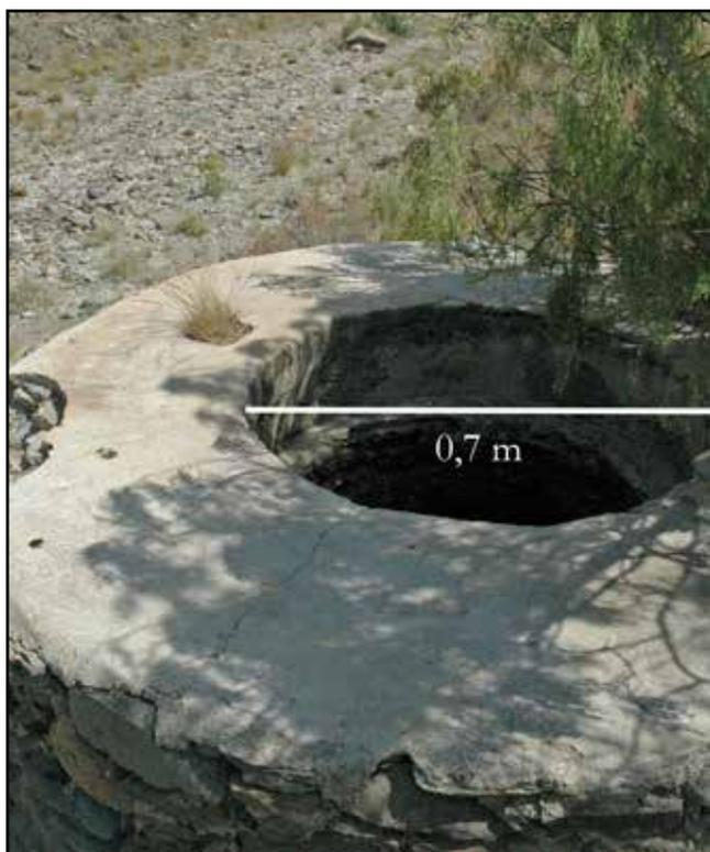
Foto N° 12: Campana n° 2 de la Mina Vieja (Fataga-Maspalomas) de corta sección 0,7 m de diámetro y profundidad 5 m.
