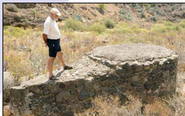
Foto N° 9: Brocal de un pozo de mina N° 2 de Guayadeque con tajamar para hacer frente a la corriente del agua del barranco.
