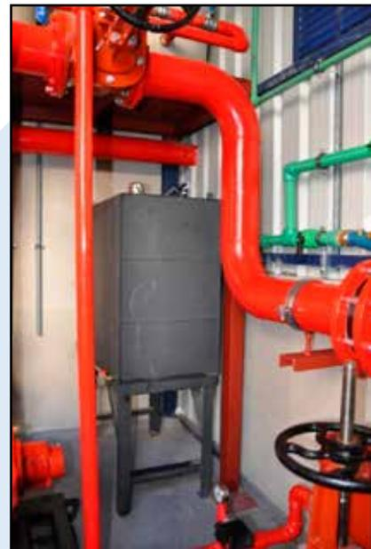
Foto N° 14 Depósito de Gasoil.
