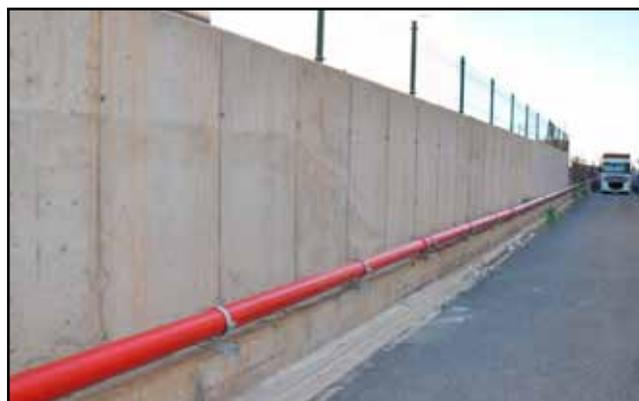
Foto N° 21: Tuberías de Hidrantes de 6 pulgadas.
