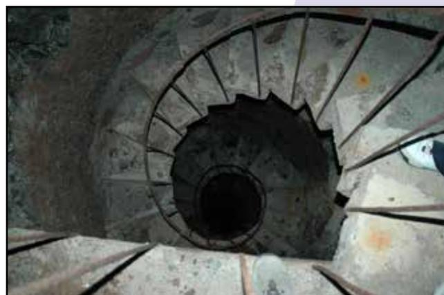
*Foto N° 6: Perspectiva desde el brocal de uno de los pozos de ventilación o campana, de la Mina de la Heredad de Sardina-Aldea Blanca (barranco de Tirajana), realizada con escalera helicoidal de hormigón armado y barandilla de hierro (diámetro 2 m, profundidad, 20 m).*
