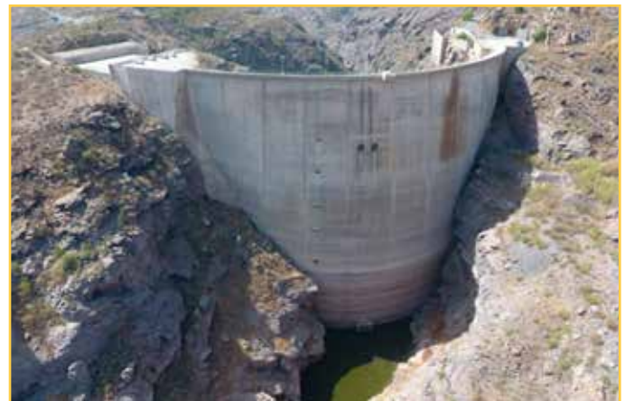
Foto Nº 1: Presa de Soria, año 2017. Fuente: CIAGC.
