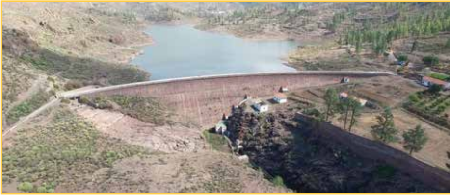
Foto N° 2: Presa de Chira desde aguas abajo. Fuente: CIAGC.
