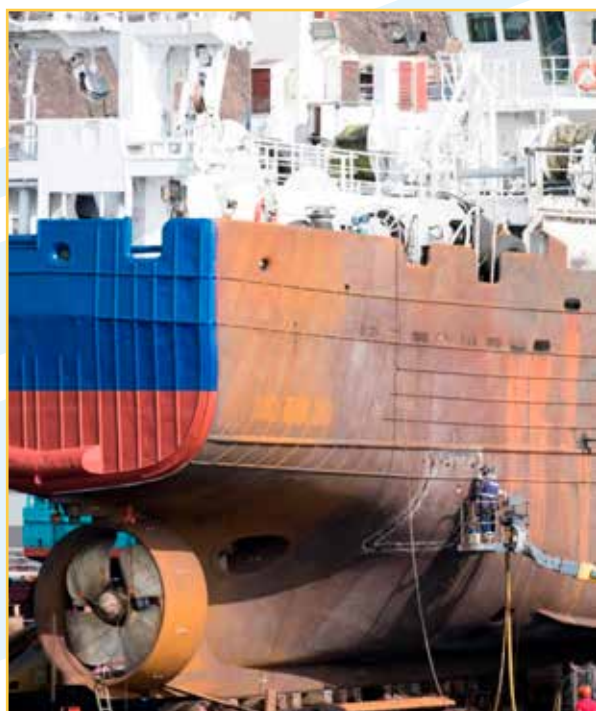
Foto Nº 4: Servicios de reparación del Puerto de Las Palmas.
