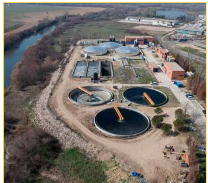
Foto Nº 2: Planta de Tratamiento de Agua.
