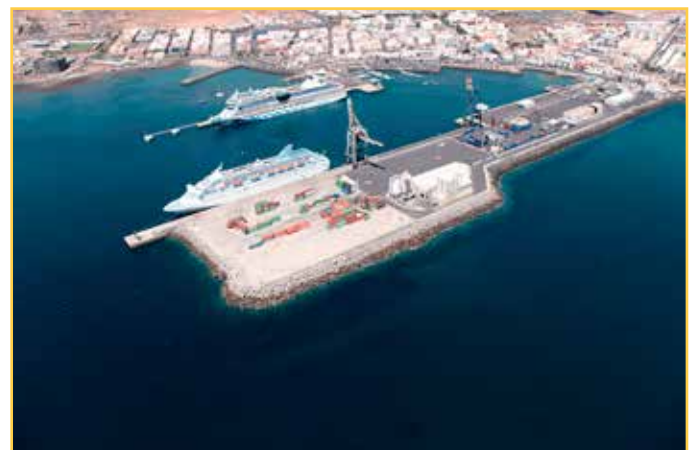
Foto Nº 3: Vista aérea del Puerto del Rosario - Fuerteventura.
