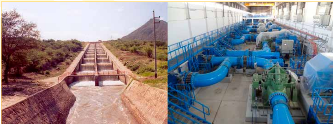
Foto Nº 7: Estación de Bombeo y Canales del Traslado Norte-Sur de Marruecos, de las Montañas del Atlas al Desierto.
