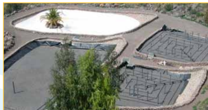
Figura N° 2: SDN de Santa Lucía en fase final de construcción en 2008. Este sistema combina humedales de flujo vertical de uso alternativo con un humedal de flujo horizontal. Fuente: ITC.
