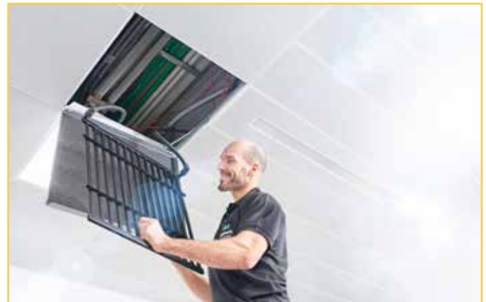
Foto Nº 3: Verificación de instalación de clima radiante en techo.
