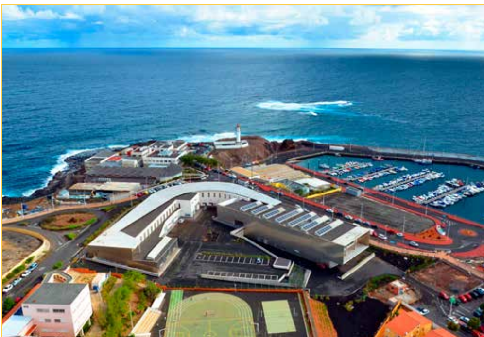
Foto N° 8: Panorámica de las instalaciones de Taliarte de la ULPGC. Foto cortesía de "Fotos Aéreas de Canarias ( www.fotosaereasdecanarias.com )".
