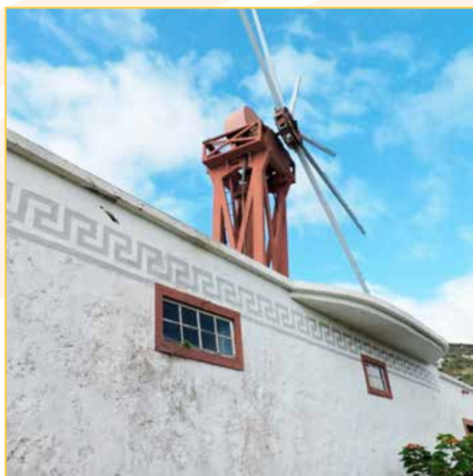
Foto Nº 1: Molino de Monte Pueblo (Villa de Mazo).
