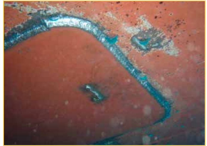
Fotos N° 1 y N° 2: Trabajos de soldadura submarina para taponar una entrada de agua de mar al interior de un buque petrolero.
