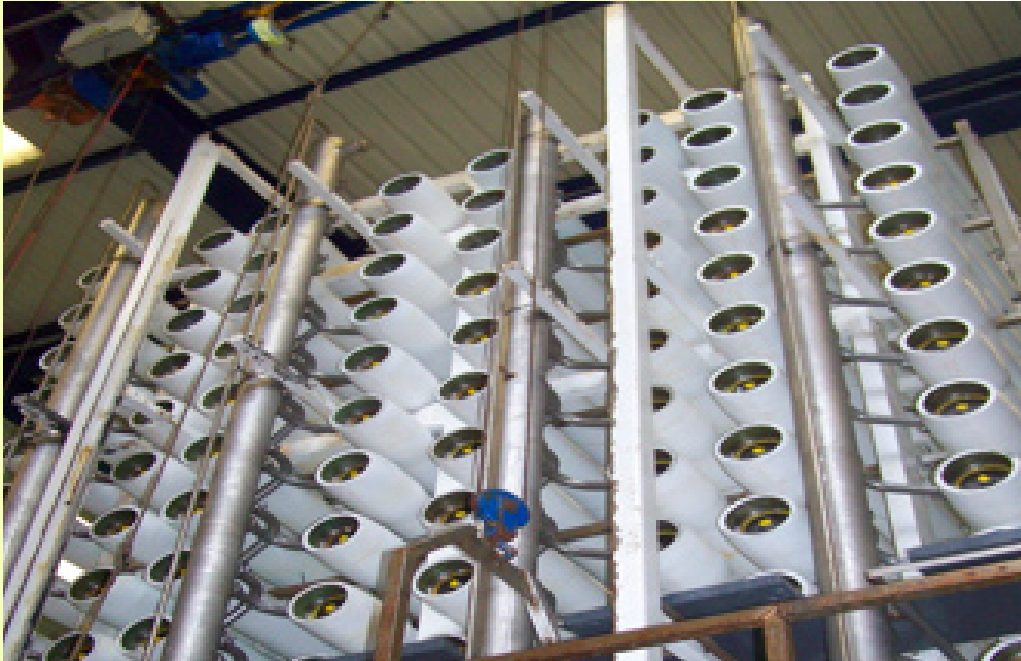
Foto: CONECTORES CIEGOS INSTALADOS Y SEÑALADOS CON COLOR AMARILLO LA TUBERIA DE PERMEADO O PRODUCTO SE TRASLADO A LA PARTE PORTERIOR
