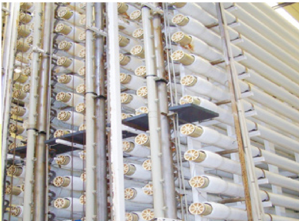
Foto: MODIFICACIONES Y COLOCACION DE LOS CONECTORES CIEGOS
