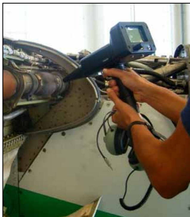
Figura 3: Inspección con equipo de ultrasonido.
