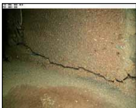
Fisura en un álave de una turbina.
