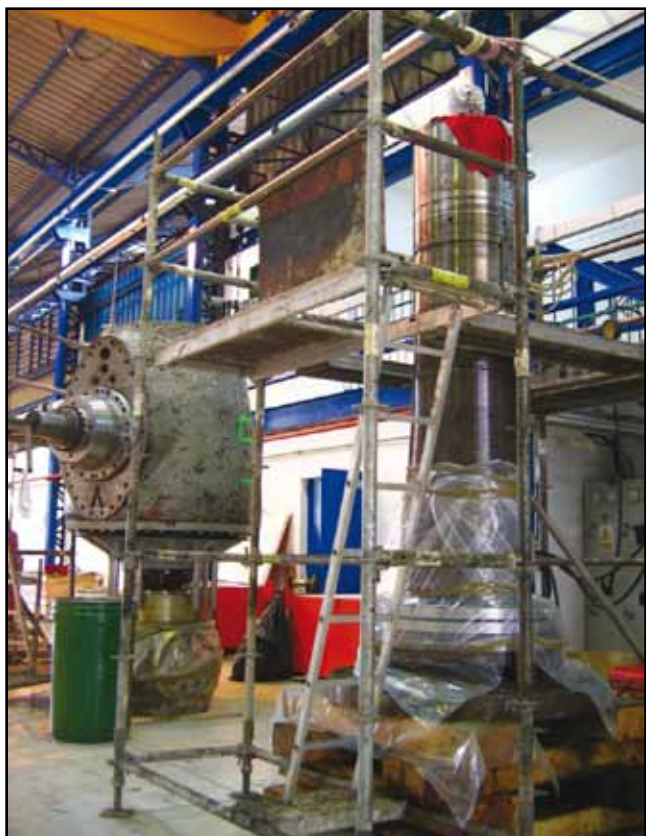
Ilustración 12: Fase de inspección y reparación.
