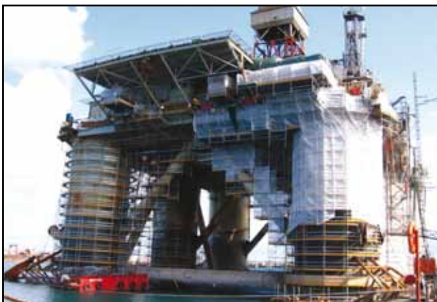
Ilustración 9: Fase de tratamiento del casco.
