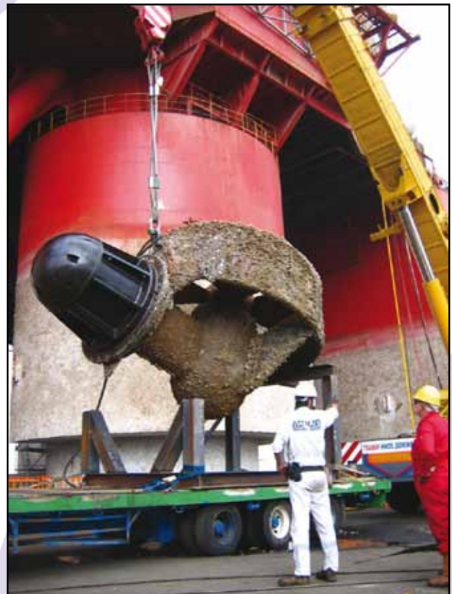
Ilustración 11: Desmontaje de una hélice de maniobra.
