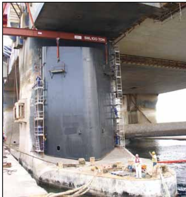
Ilustración 6: Montaje de un tanque blister en proa. Peso 52 toneladas.
