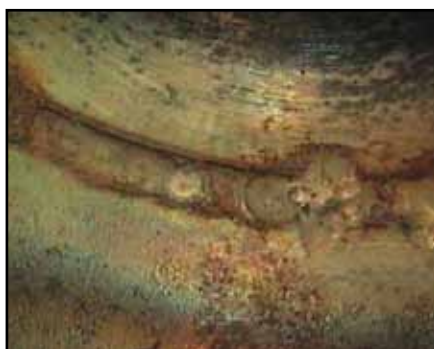
Control de cordón de soldadura.
