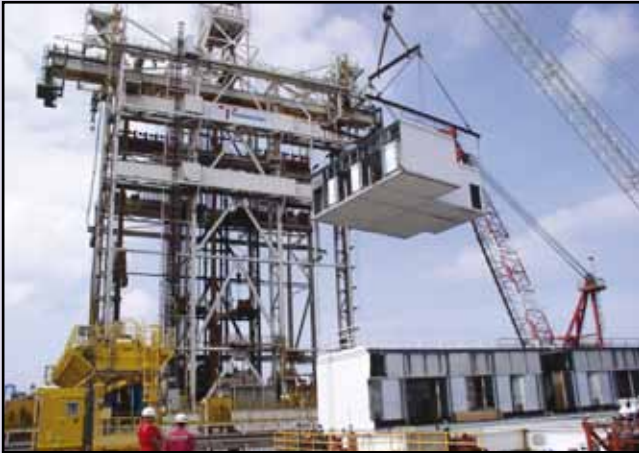
Ilustración 7: Montaje de los módulos de la nueva Habilitación.
