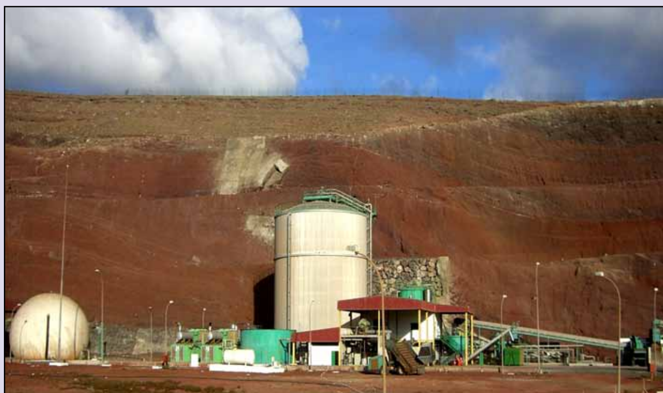
Foto N° 1: Vista panorámica de la Planta de biometanización.
