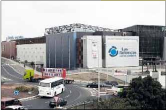
Foto N° 8: Centro Comercial Las Rotondas.
