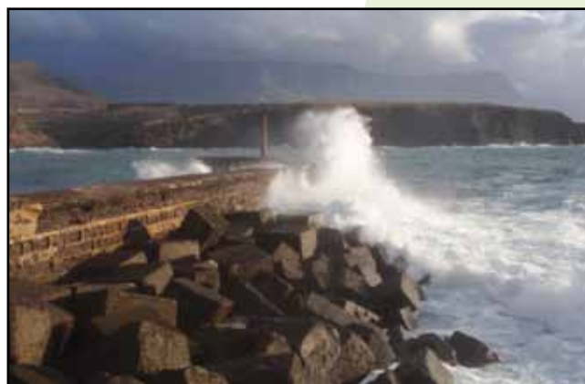
Figura N° 8: Rotura del oleaje contra el dique.
