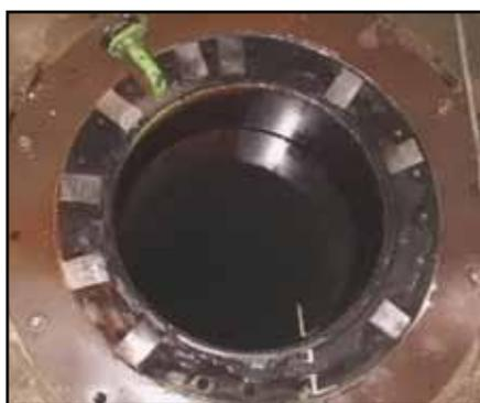
Fotografía N° 4: Detalle brida de bancada al levantar la bomba.
