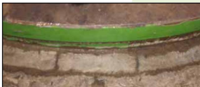
Fotografía N° 5: Detalle grietas en bancada.
