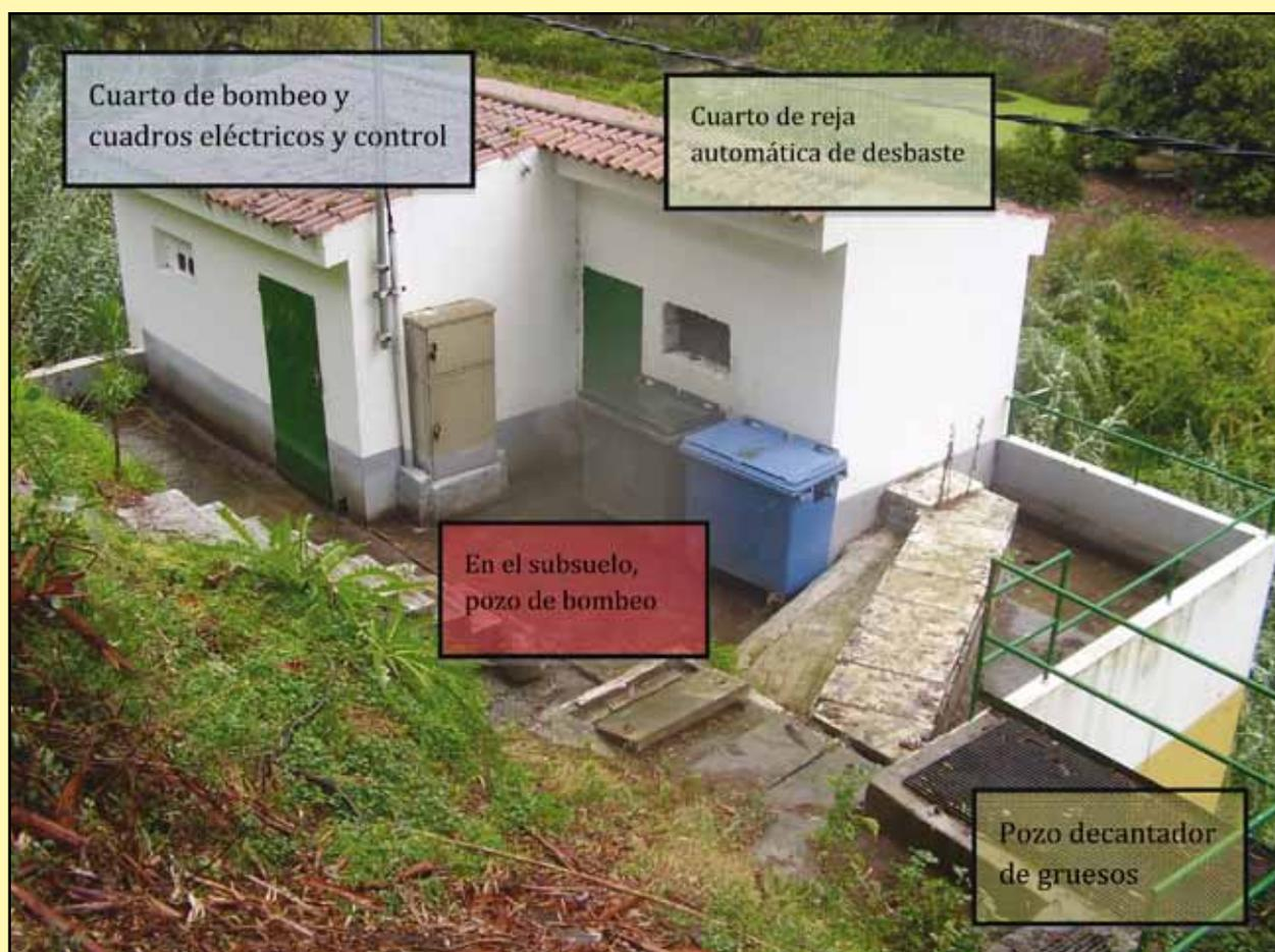
Fotografía N°1: Localización exterior de una EBAR y descripción general de la misma.
