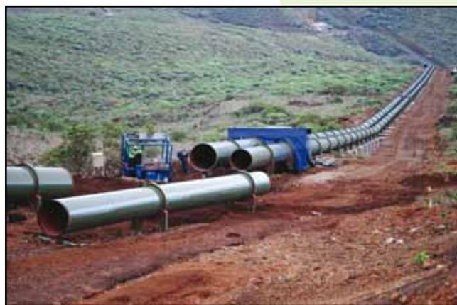
Fotografía N° 6: Detalle de la Instalación de Conducciones Forzadas.
