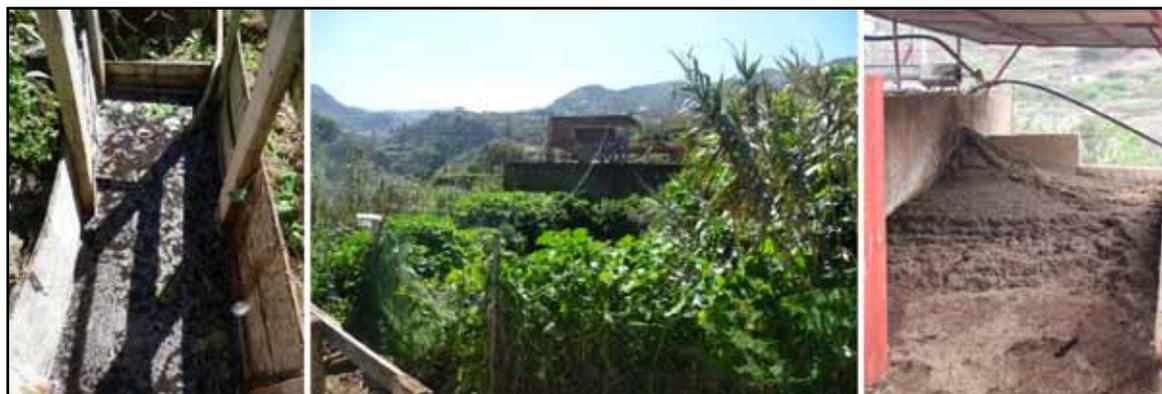
*Foto N° 3: Arqueta final de depuración (izquierda), vista de la laguna y al fondo digestor- tamiz (centro) y estercolero de recogida de sólidos (derecha).*
