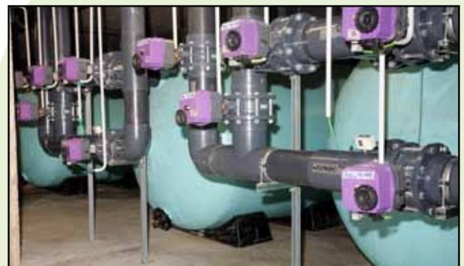
*Foto N° 10. Filtración de piscinas de 50 metros.*
