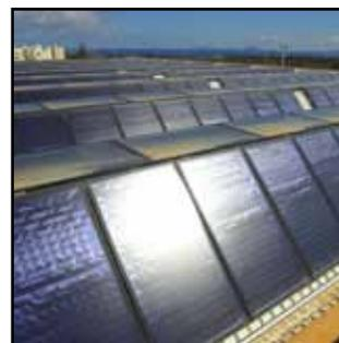
Foto N° 7: Colector solar térmico para ACS, absorción y calentamiento de piscinas.
