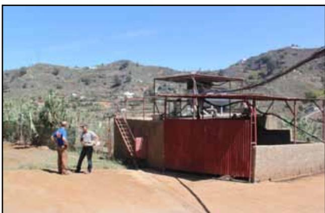
*Foto N° 2: Estercolero de sólidos adosado al biodigestor y el separador encima. Detrás se sitúa la laguna y los humedales.*
