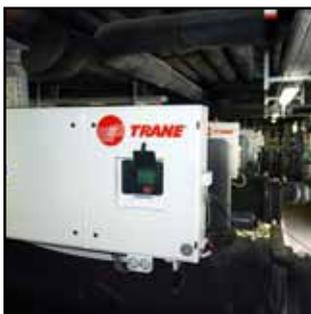
Foto N° 4. Bombas de calor utilizadas para la geotermia.
