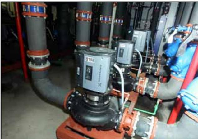
*Foto N° 8. Bombas de recirculación con variadores de frecuencia.*
