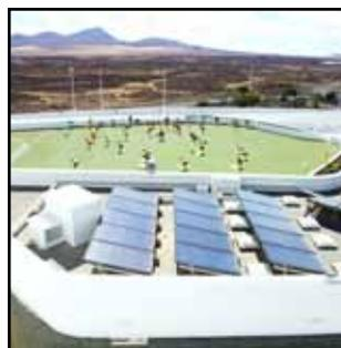
Foto N° 6: Colector solar térmico destinado a ACS, absorción y calentamiento piscinas.
