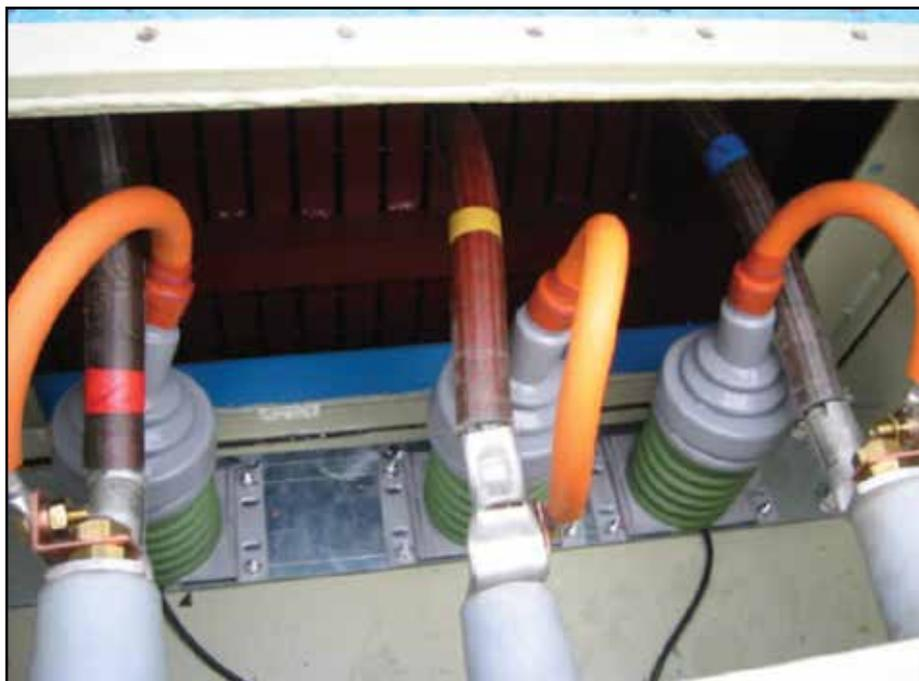
Figura N° 3: Ejemplo de montaje de sensores DP en la Terminal Box de un motor.
